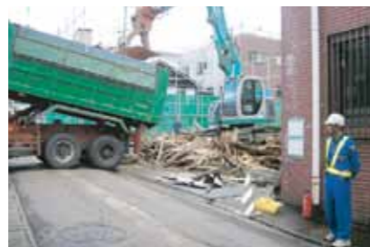
木造解体工事（誘導員設置）
