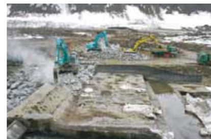
河川内構造物解体工事
