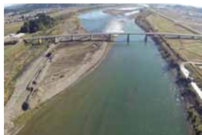
工事現場進捗状況写真
