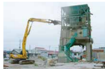
鉄骨造解体工事
