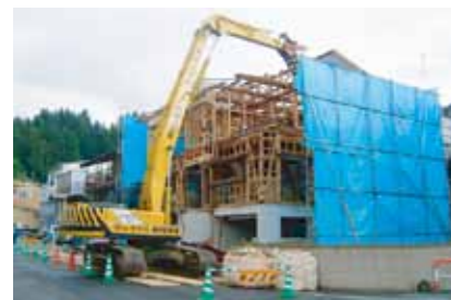
木造（高床式）解体工事
