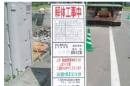
解体工事中看板設置
