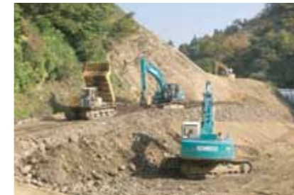
道路工事（山古芯）
