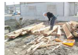
解体工事現場での分別・仕訳作業
