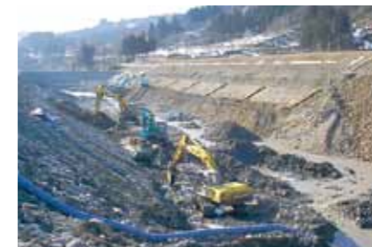
河川工事（信濃川）
