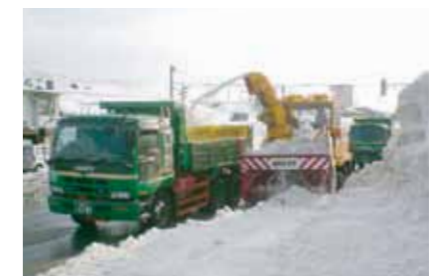
除雪作業状況
