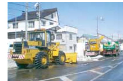
除雪作業状況
