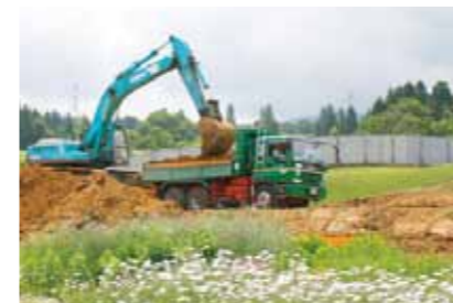
リゾート開発工事
