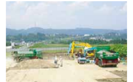
宅地造成工事
