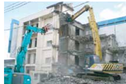
RC（コンクリート）造解体工事
