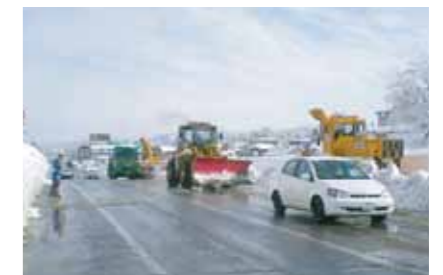
除雪作業状況
