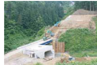
道路工事（八箇道路）
