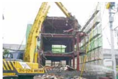
鉄骨造解体工事
