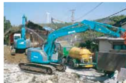
木造解体工事（中越沖地震）
